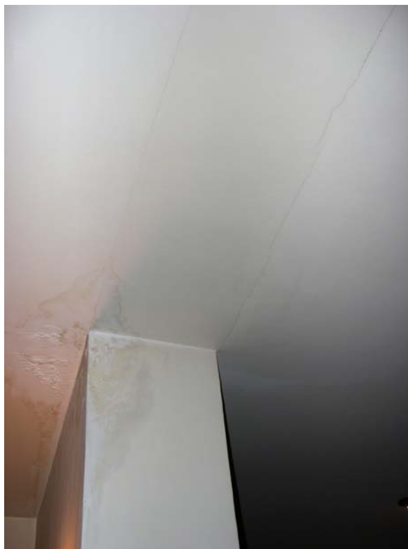
Fig. 2– Particolare del muro divisorio fra il soggiorno e la cucina.
